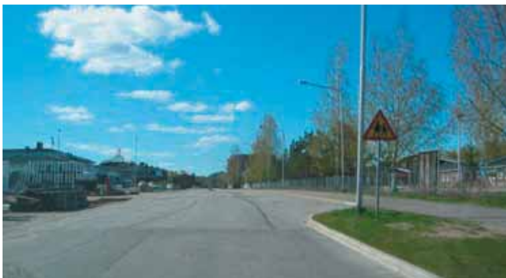
Kuva 12.5-2. Koulumestarintien eteläpuoli on leveä ja epämääräisen oloinen. Kouulaisten jättopaikka leventää väylää entisestään.
