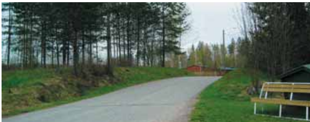
Kuva 14.5-2. Koivukujan pystygeometriaa tasataan näkemien parantamiseksi.
