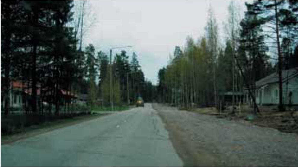
Kuva 3.4-11. Orimattilassa kevyen liikenteen väylä on rakenteilla Arolantien varteen.
