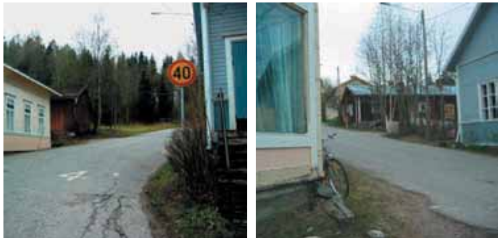
Kuvat 3.4-9 ja 3.4-10. Hämeenkoskella Toijalantien ja Pätiäläntien liittymässä sijaitsevat rakennukset aiheuttavat näkemäesteen.
