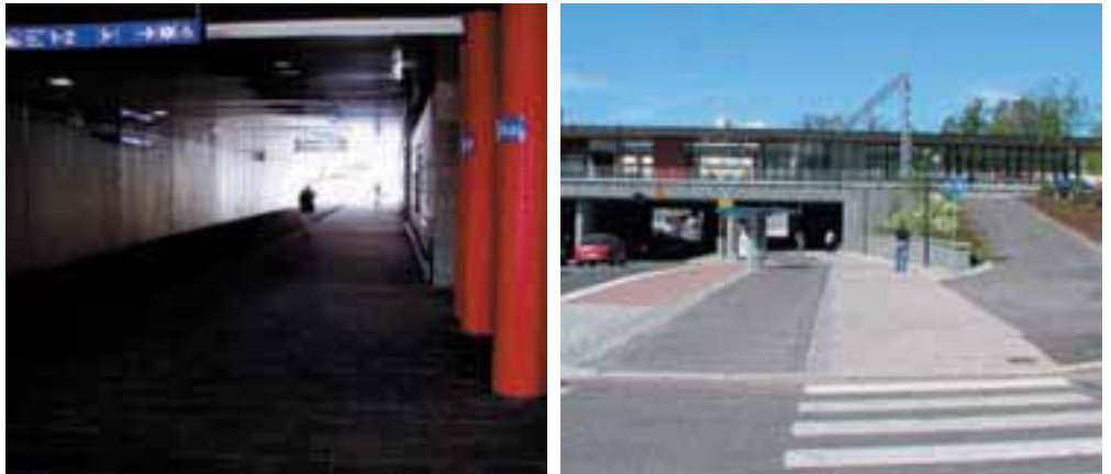
Kuvat 3.4-14 ja 3.4-15. Lahden rautatieaseman alikulkutunneli on päiväsaikaan pimeä muuhun ympäristöön nähden.
